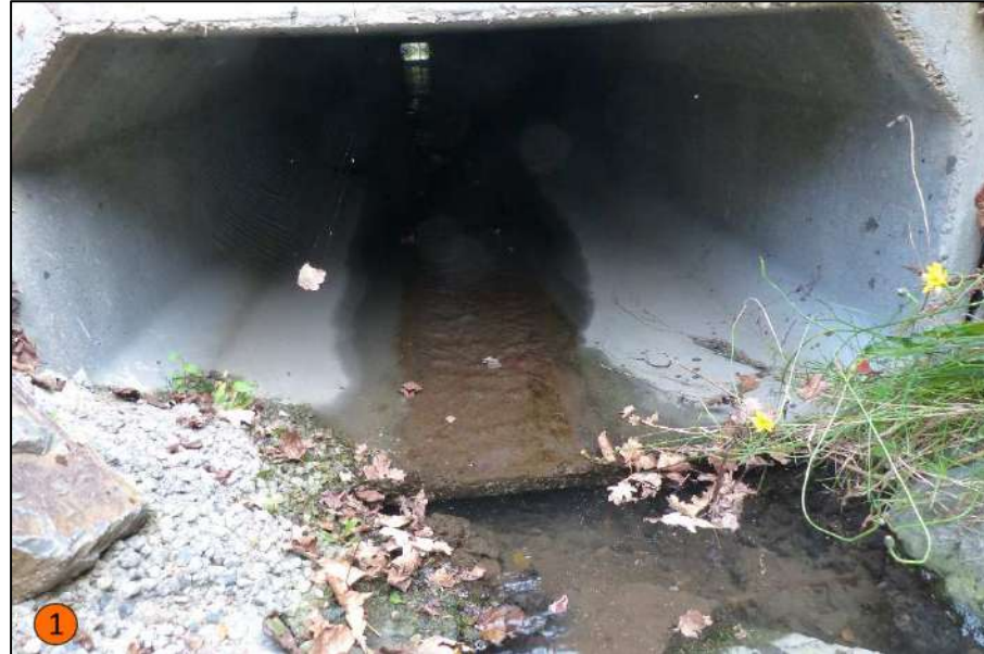
Photo 51: Vue du dalot canalisant le ruisseau sous l'avenue de Baiersdorf (IAO SENN 2021)
